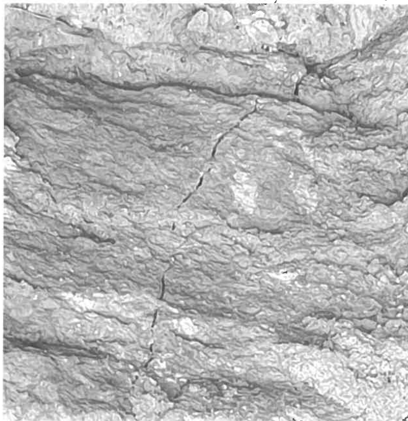
Kościół p.w. św. Augustyna w Świętochłowicach. Odkrywka fundamentu po stronie północnej. Widoczne pęknięcie kamiennego wątku ściany.
