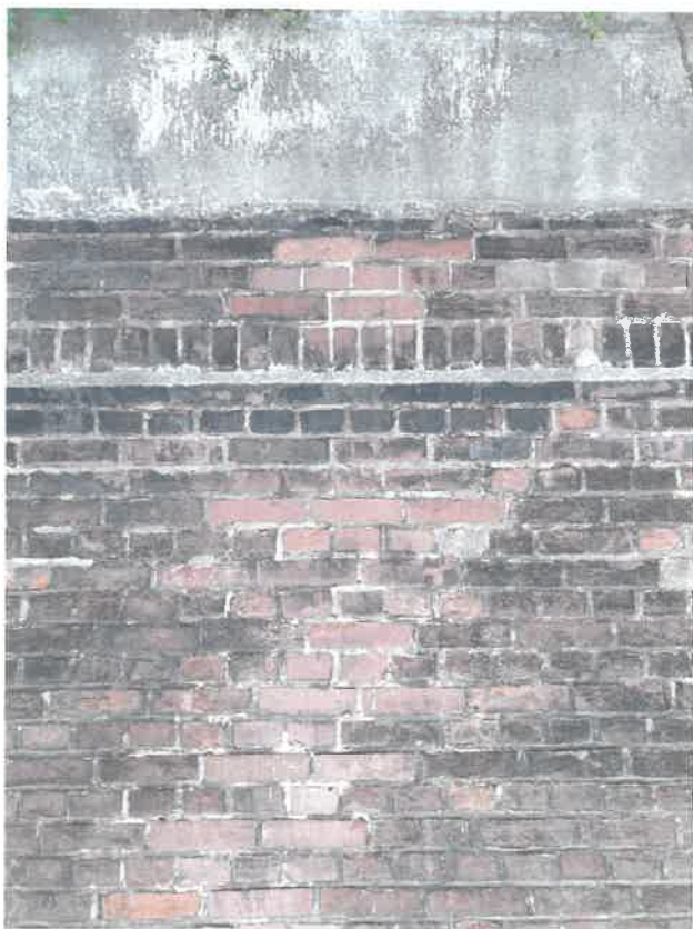
Przemurowania elewacji kościoła. Stan przed remontem.
