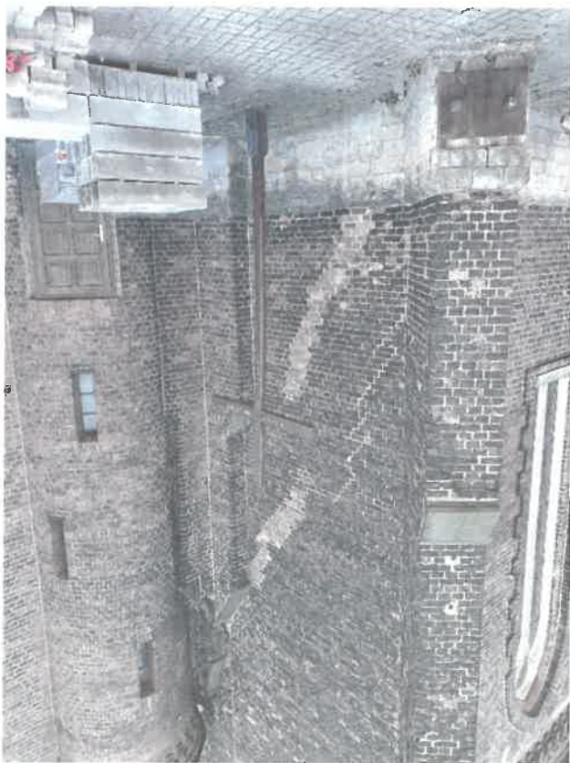
Przemurowania elewacji kościoła. Stan przed remontem.
