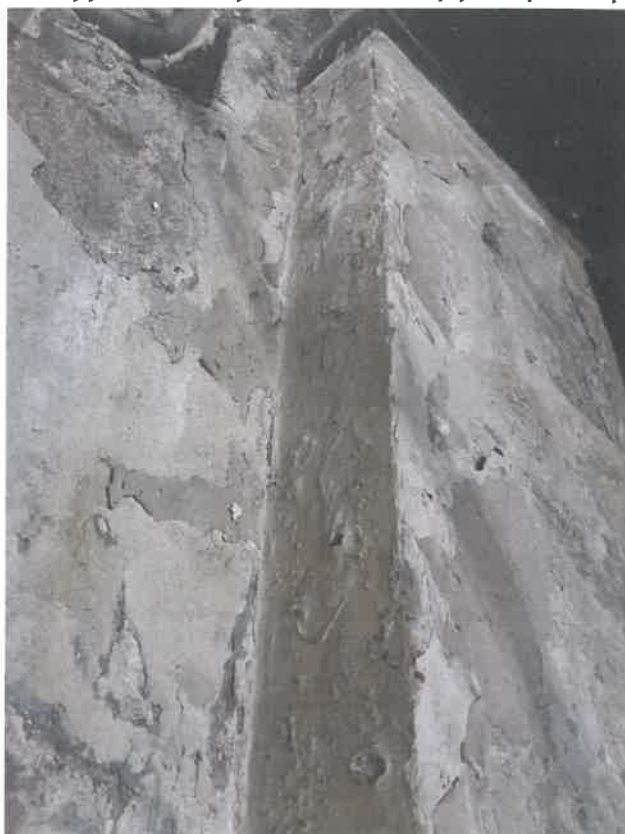
Stan zachowania tynków wewnętrznych, stan przed konserwacją.
